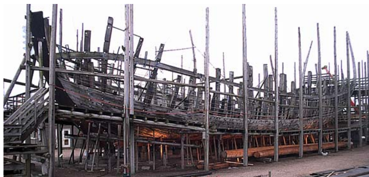
Fig. 3. The "7 Provinciën" under construction
